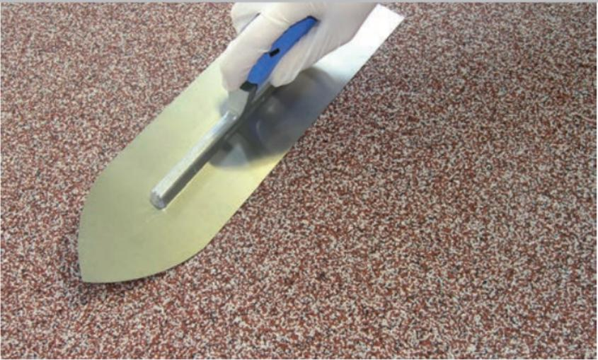
Der Mischansatz kann anschließend auf die noch nasse Klebeschicht ausgeschüttet und mit einem Handaufstreichspachtel bahnenweise verteilt werden. Danach wird der Mischansatz mittels Glättkelle unter Druck verdichtet und lunckerfrei geglättet.
